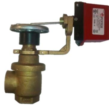
L'interrupteur de surveillance de la pression, numéro de pièce PL est utilisé pour vérifier la pression de l'eau entrante. Cet interrupteur est pré-réglé sur 40 PSI, mais il est ajustable jusqu'à 60 PSI, pour tenir compte des différents systèmes de hottes.
